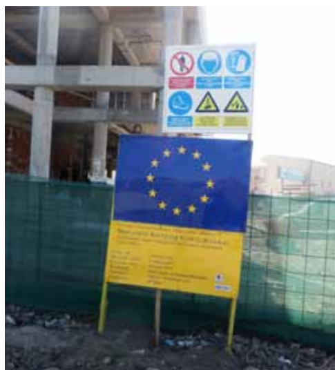
Izgradnja zgrade Opštine Klokot
